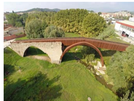
Pont Trenca en Sant Celoni. Barcelona
