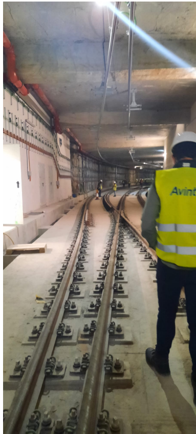
Ampliación Metro de Málaga
