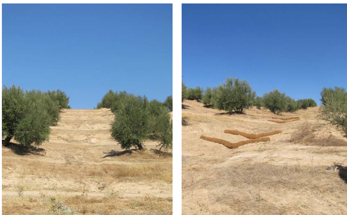
Figura 2. Ejemplo de pendiente con cárcavas e implantación de filtros en las mismas
