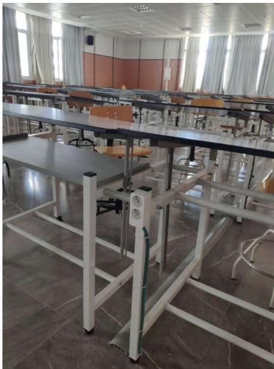
Se ha procedido a la instalación del cableado en las aulas 104, 110, 201, G1A, G1B y G3 para que todos los puestos tengan conexión eléctrica. Por una parte, se ha adquirido el material para la 104, 110, 201 y 103 y el equipo de mantenimiento del Campus de Fuentenueva lo ha instalado durante el transcurso del año (a falta de la 103). Por otro lado, se ha contratado una
